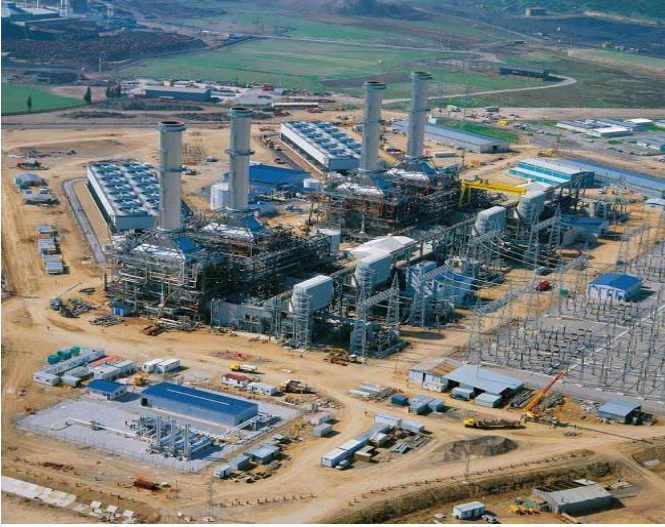
ENKA İnşaat – ENKA Power Aliğa Çevirim Santrali
